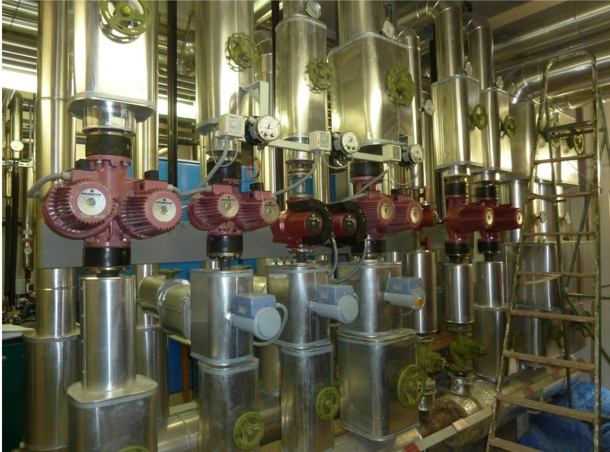
**Abbildung 1: Installierte Standardstufenpumpen**
